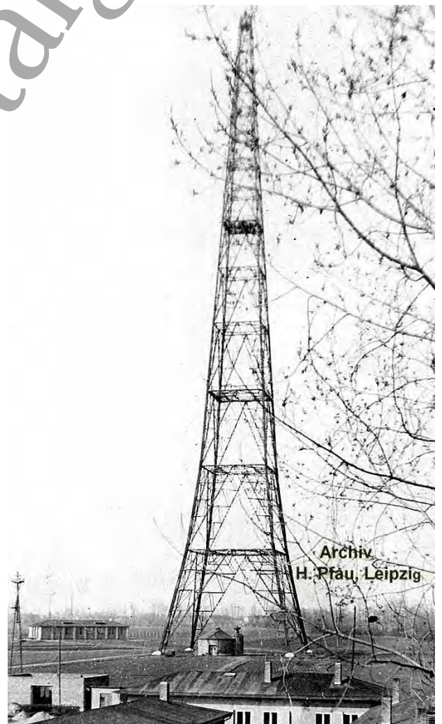
Bild 33: Antennenturm von 1935, darunter steht das Antennen-Abstimmhäuschen.
