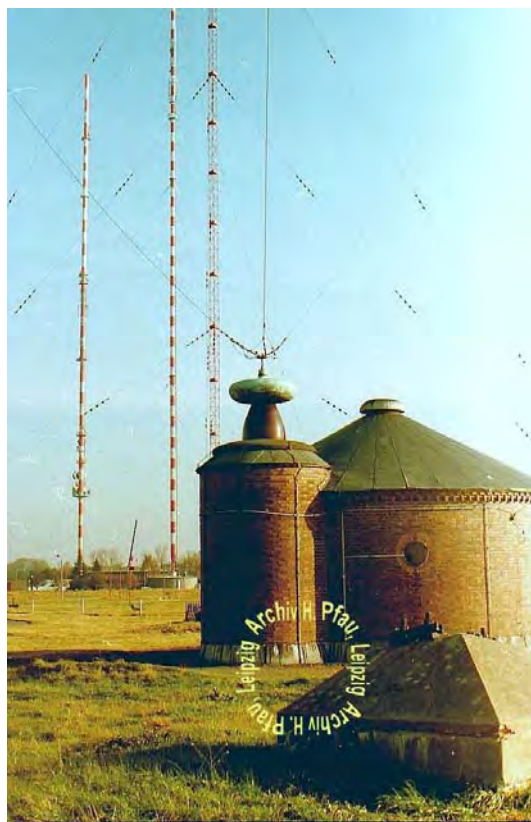
Bild 39: Antennen-Abstimmhaus (1936) unter dem damaligen Holzturm. Davor das Fundament eines Turmfußes davon. Im Hintergrund die beiden heute noch stehenden Rohrmasten und ein Stahlgittermast.
